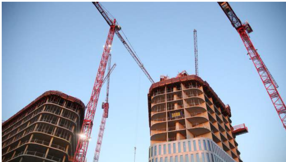
Am künftigen Hotel (rechts im Bild) wird bereits an der Fassadenverkleidung gearbeitet. (Foto: Johannes Simon)
